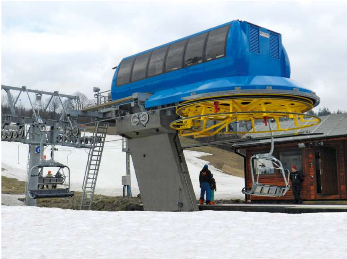
Slika 1.1.a: Primer spodnje, pogonske postaje podobne sedežnice CF4 Wisla Klepki Malinka na Poljskem [3]
